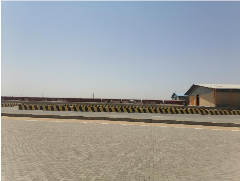
شکل ۸. سوله یک هکتاری برای انبارش کالاهای فله و استقرار سازمان‌ها و دستگاه‌های مجوزدهنده
