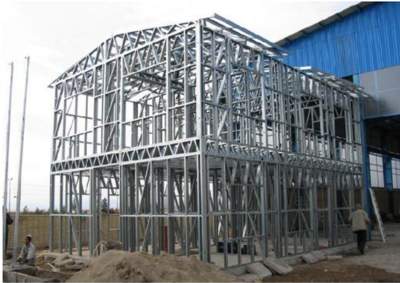
شکل ۱۰. سیستم ساختمانی LSF
