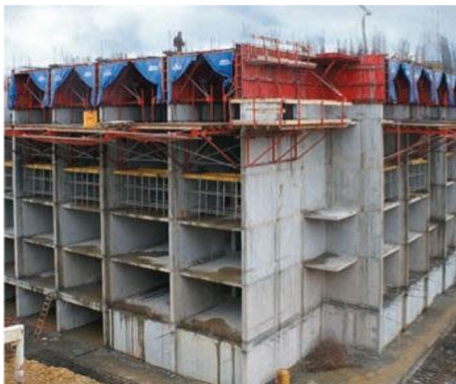
شکل ۱۲. ساختمان با سیستم قالب تونلی
