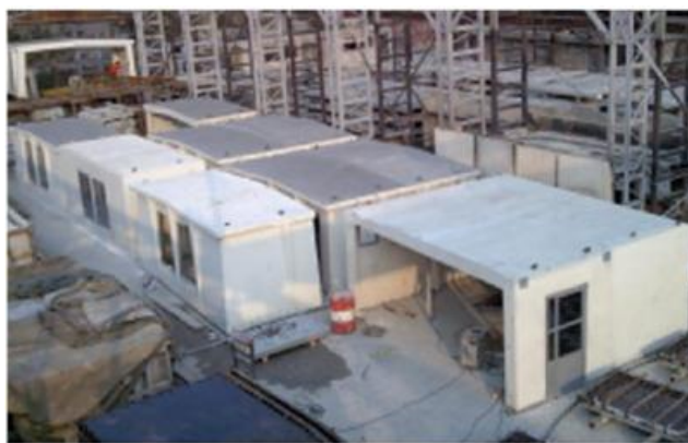
شکل ۲۱. سیستم سازه‌ای بتن مسلح پیش‌ساخته مدولار سه‌بعدی
