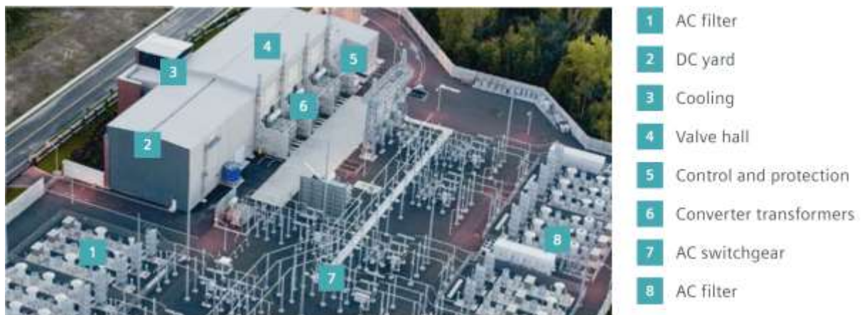
شکل ۴- معرفی اجزای ایستگاه مبدل با فناوری LCC
