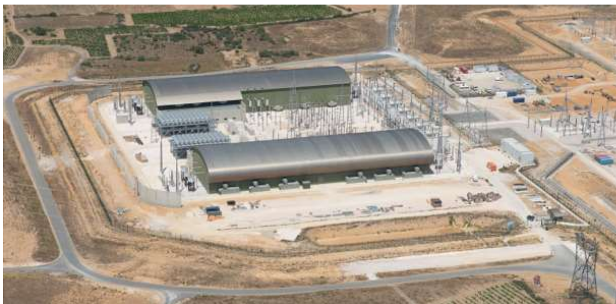
شکل ۲- ایستگاه مبدل سیستم انتقال HVDC ۲۸۰۰ مگاوات فرانسه-اسپانیا
